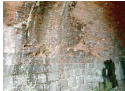
▲春日野隧道内側
