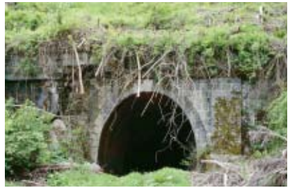
春日野隧道武生側入口
