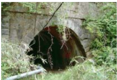
旧金ヶ崎隧道北側入口
